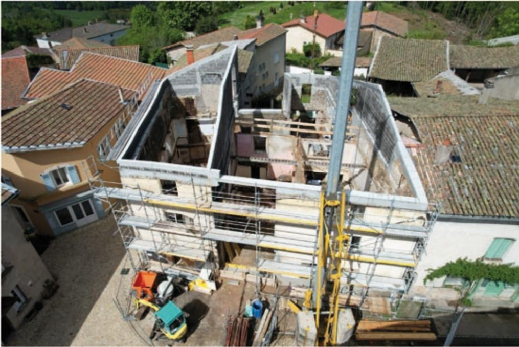
Si, vu de l'extérieur le chantier parait ne pas avancer, en fait il s'est déjà fait beaucoup de choses. Après les démolitions et les ouvertures, les reprises en béton des hauts de murs et des bases (caves, escaliers) se poursuivent afin de fixer et couler les dalles de chaque étage et les jambages des grandes ouvertures.
